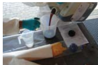
Forberedelse af installation, rørhat monteres på packer. Harpiks i form af silikat/vandglas blandes.
