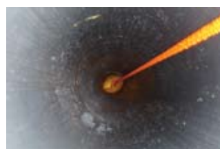
Packerens indføring/placering i røret, kontrolleres med tv.
